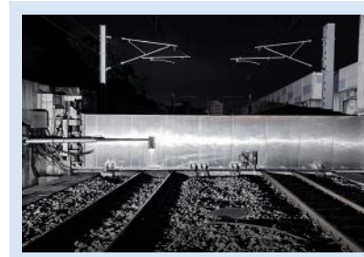
鳳山車站 防洪閘門
