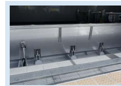
台北捷運松山站 電動油壓掀式水閘門
